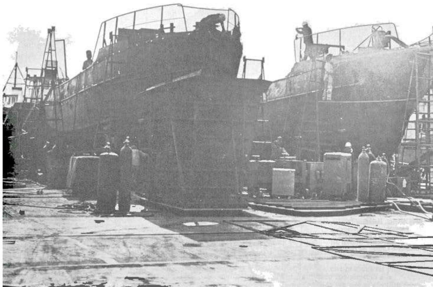
Vista de la construcción de camaroneros cubanos en Fabrimet
