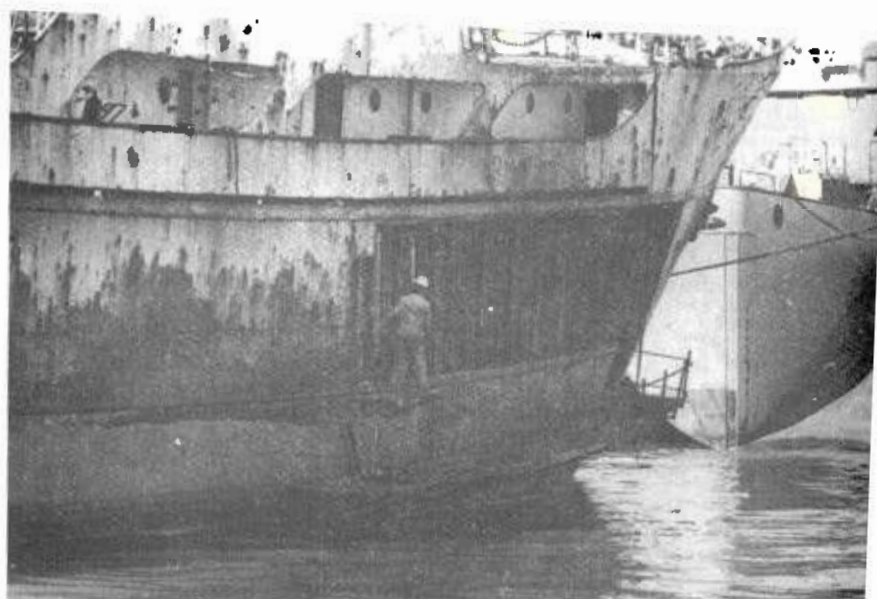
Reparación capital de la banda de estribor...
