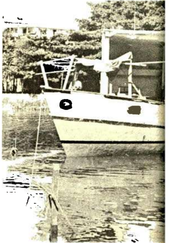
Un buque de ferrocemento, el primero en Cuba, flota majestuosamente.
