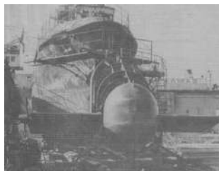
Монтаж волнового движителя на траулер типа «Балтика» (фото из газеты «Красная звезда», 19.11.1994 г.)
