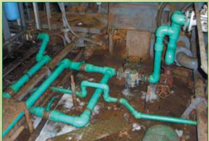
Установка новых систем в трюме судна
