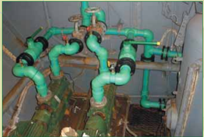
«Марина Цветаева» - пластмассовые трубопроводы и насосы пресной воды
