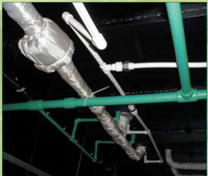
Монтаж пластмассовых трубопроводов завершен
