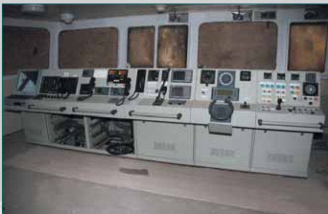
Монтаж пульты судовождения производства ОАО «Николаевская ЭРА»
